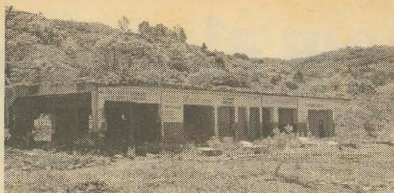
Do centro comercial da cidade velha só sobrou isto
