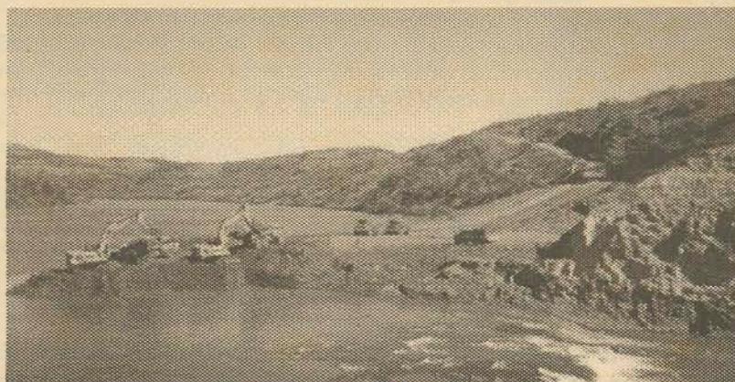
Desmanchando uma ensecadeira
