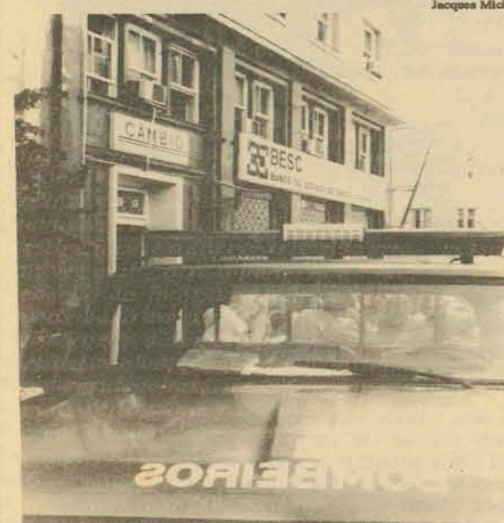
Curto-circuito em instalação precária fez bombeiros atenderem a agência Praça XV
