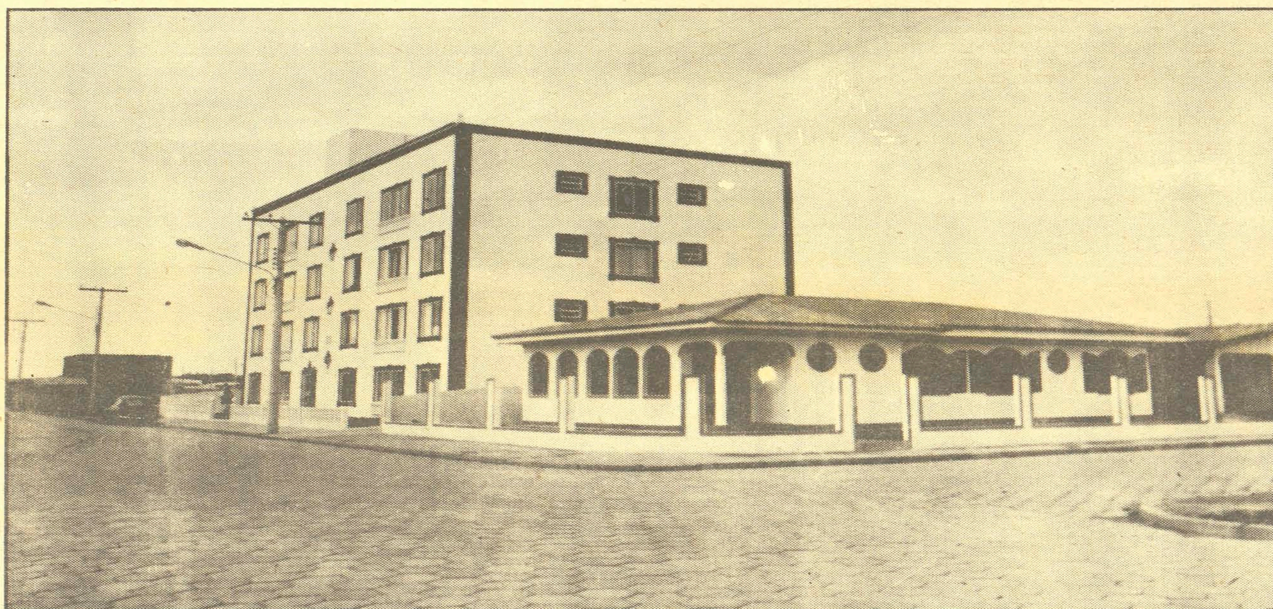
Mais de 160 unidades residenciais implantadas, entre edifícios e casas, fazem o Loteamento Kobrasol uma sólida realidade.
