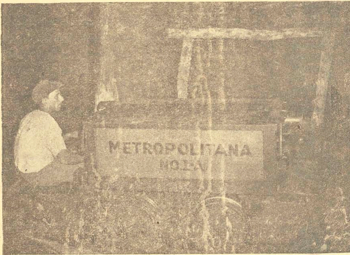
Locomotiva elétrica de acumuladores com capacidade de transporte de 20 toneladas
