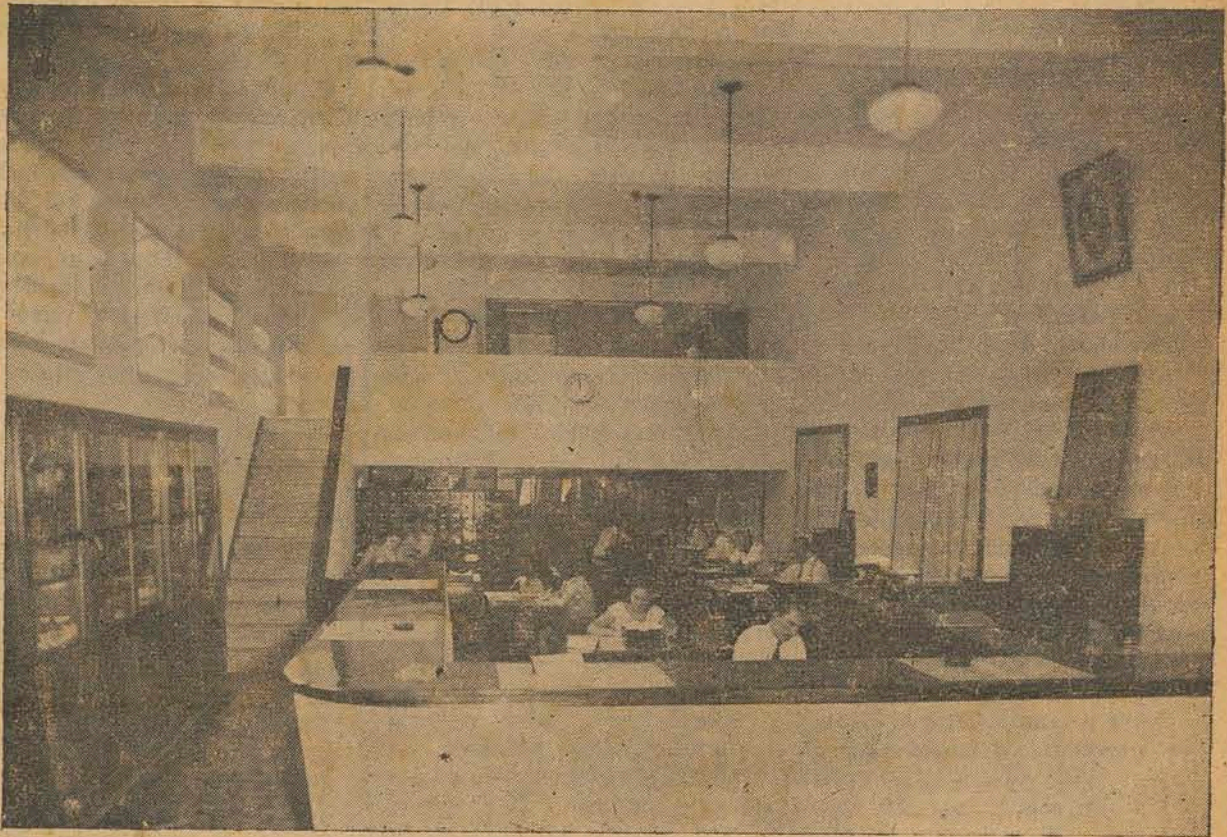
Vista interna do edifício "Santa Teresinha", de Machado & Cia. S. A.
