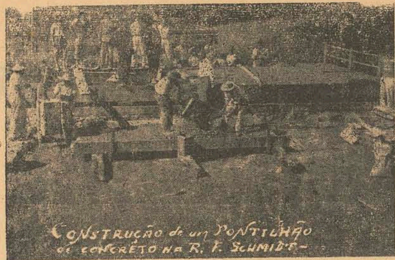
Construção de um pontilhão
