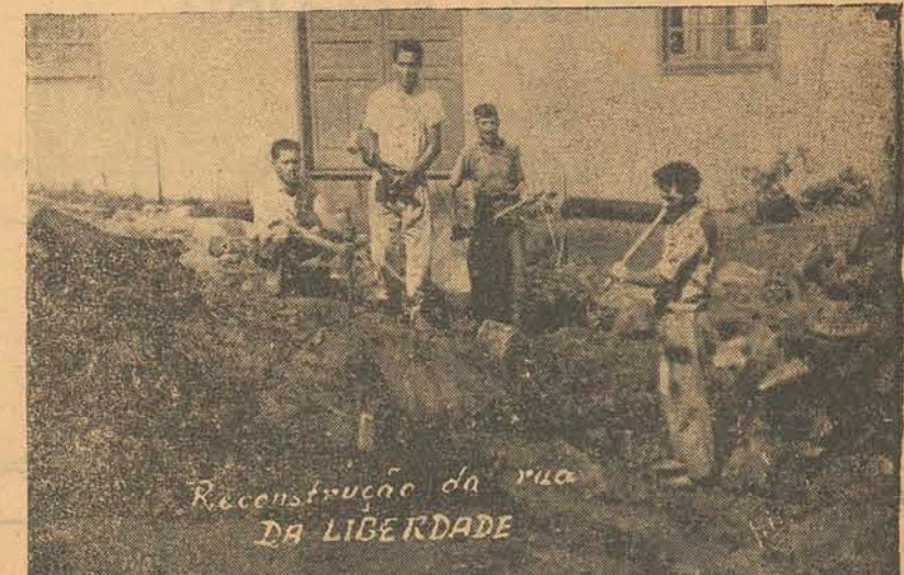
Reconstrução da rua da Liberdade
