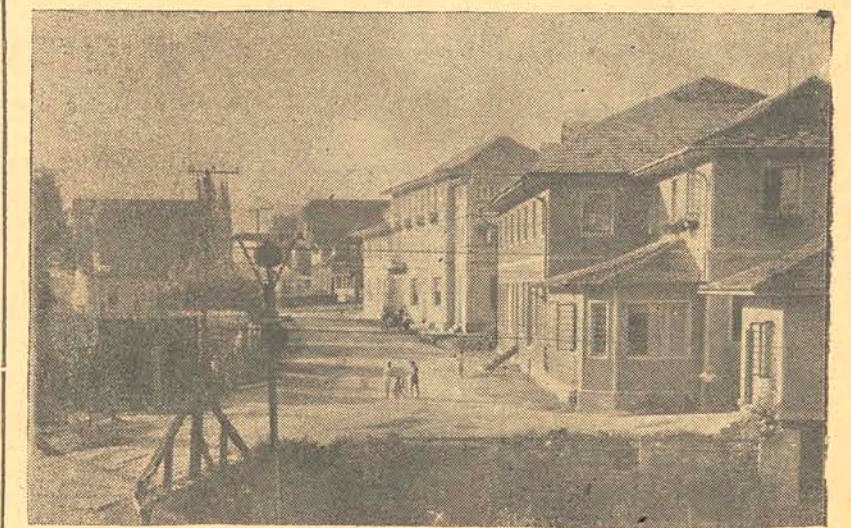
Trecho da Av. Nerêu Ramos, vendo-se ao centro o novo hotel (ainda em construção), da sra. Leonida Kurth
