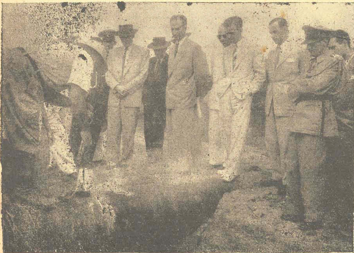
Fotografia batida no ato de enchimento da primeira junta de cano, da nova adutora de água para Florianópolis, presentes o sr. Interventor Federal dr. Udo Deeke e autoridades
