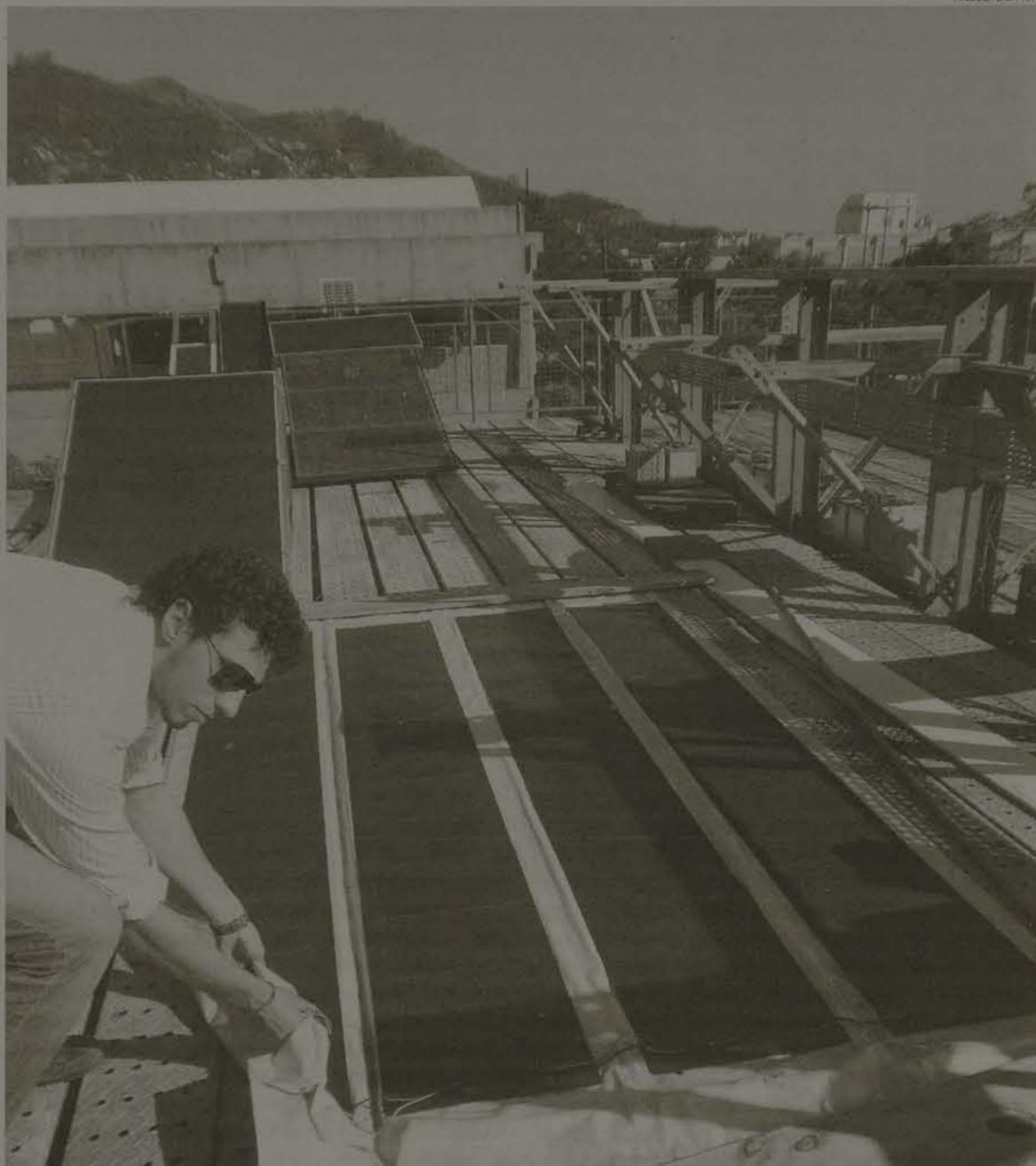
Lucas Nascimento, bolsista do LabSolar, mostra placas solares fotovoltaicas moldáveis no terraço do prédio de Engenharia Mecânica da UFSC
