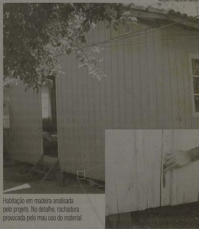
Habitação em madeira analisada pelo projeto. No detalhe, rachadura provocada pelo mau uso do material
