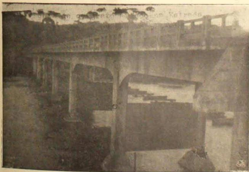
Ponte de concreto armado, com 117 metros de comprimento, sôbre o Rio Marombas, entre Campos Novos e Curitiba.
