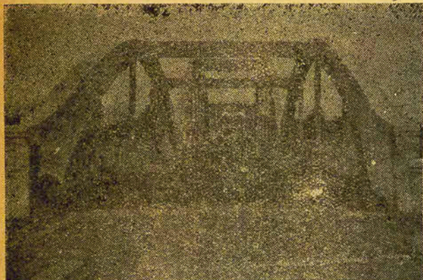
PROVA DE RESISTENCIA DA PONTE INDAIAL (TOMBÓ) QUE É SERVIDA POR CONSIDERAVEL ESTRADA DE RODAGEM
