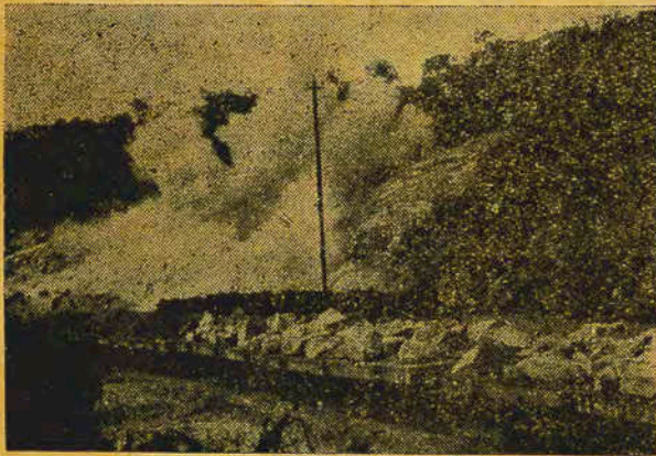
Pedreira do Linguado, vendo-se a explosão de 35 minas
