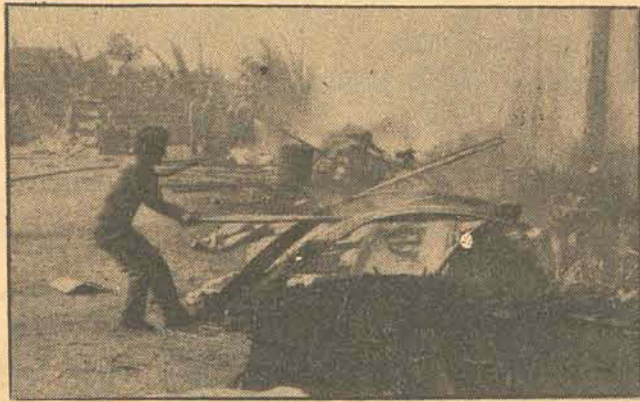
O setor de oficina e pintura foi totalmente destruído...
