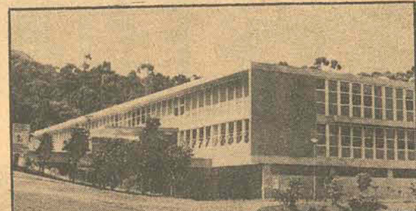
O novo hospital infantil, próximo ao Hospital Nereu Ramos.
