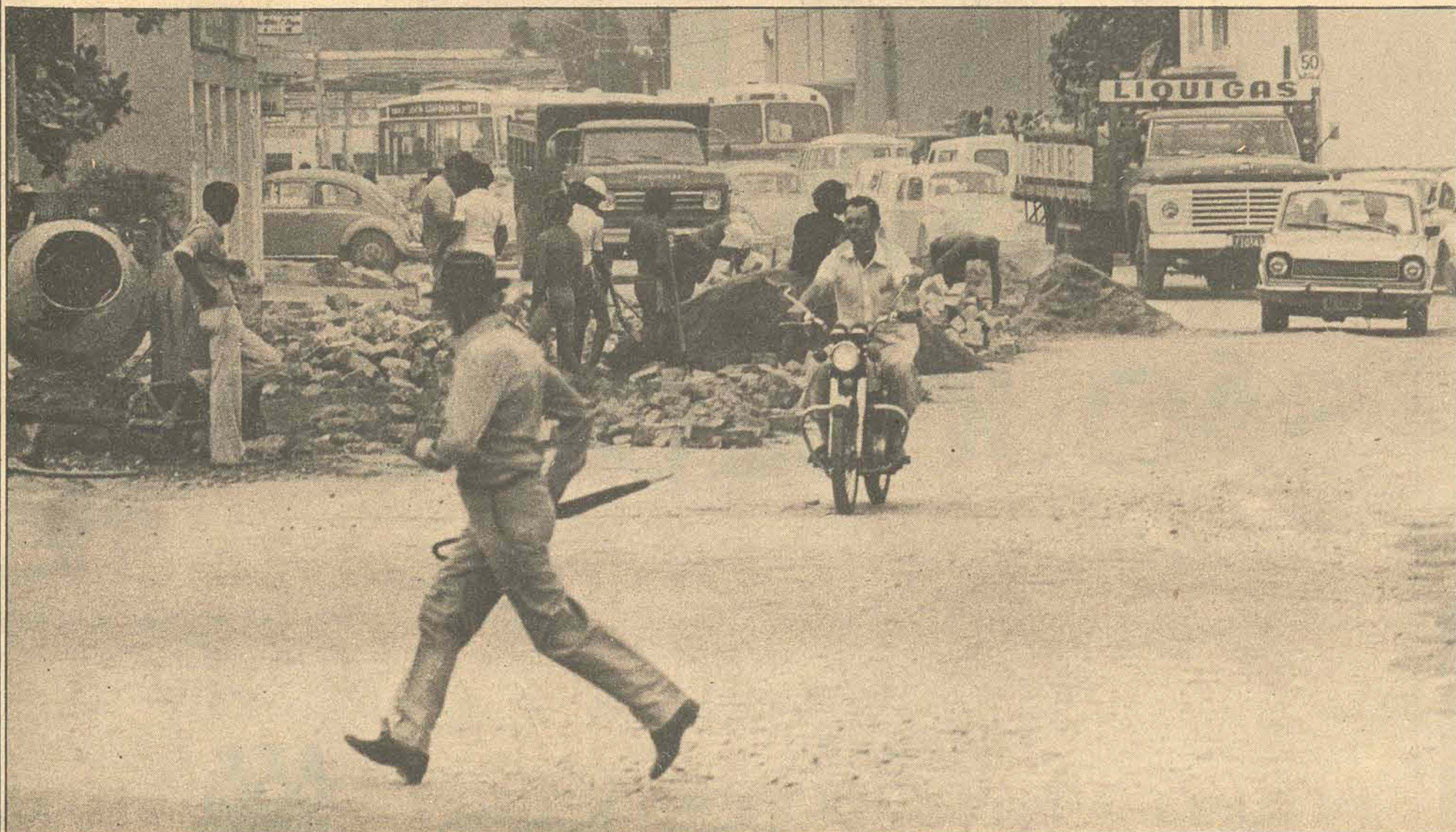
O trânsito na Avenida Presidente Kennedy, normalmente confuso, está ainda mais difícil com as obras que ali se realizam (Pág.16).
