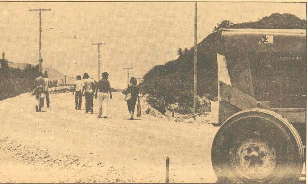
Obras interrompem o trânsito e os moradores tem que ir a pé para casa.
