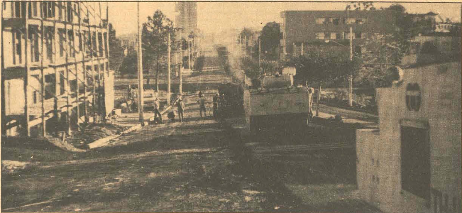
Os trabalhos de asfaltamento
