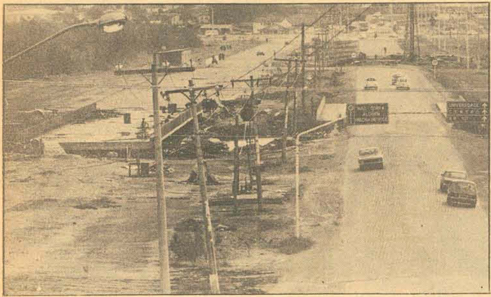
Para o andamento dos serviços, o trânsito para a Lagoa foi desviado.
