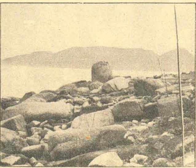
Esta parte será aterrada para alargar a estrada.
