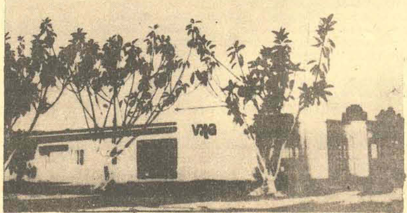
Hospital Camboriú, Rua Florianópolis, 500 - Camboriú, SC.
