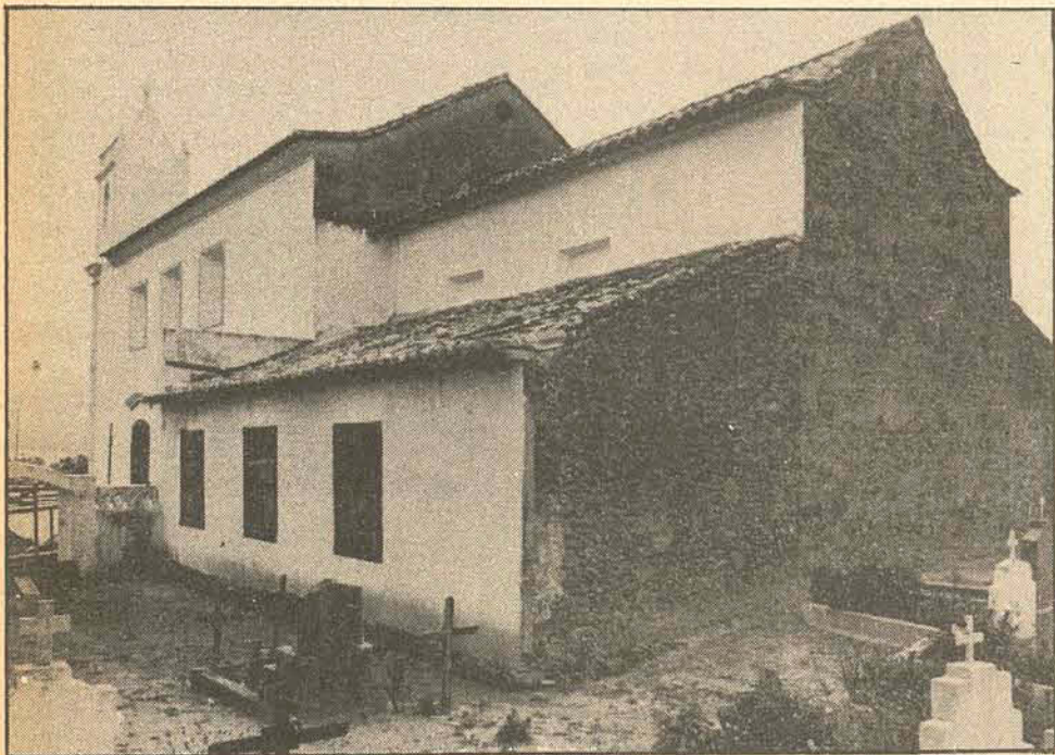
Igreja Nossa Senhora da Lapa: obras pela metade.
