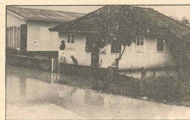
Residência tomada pelas águas em Barreiros
