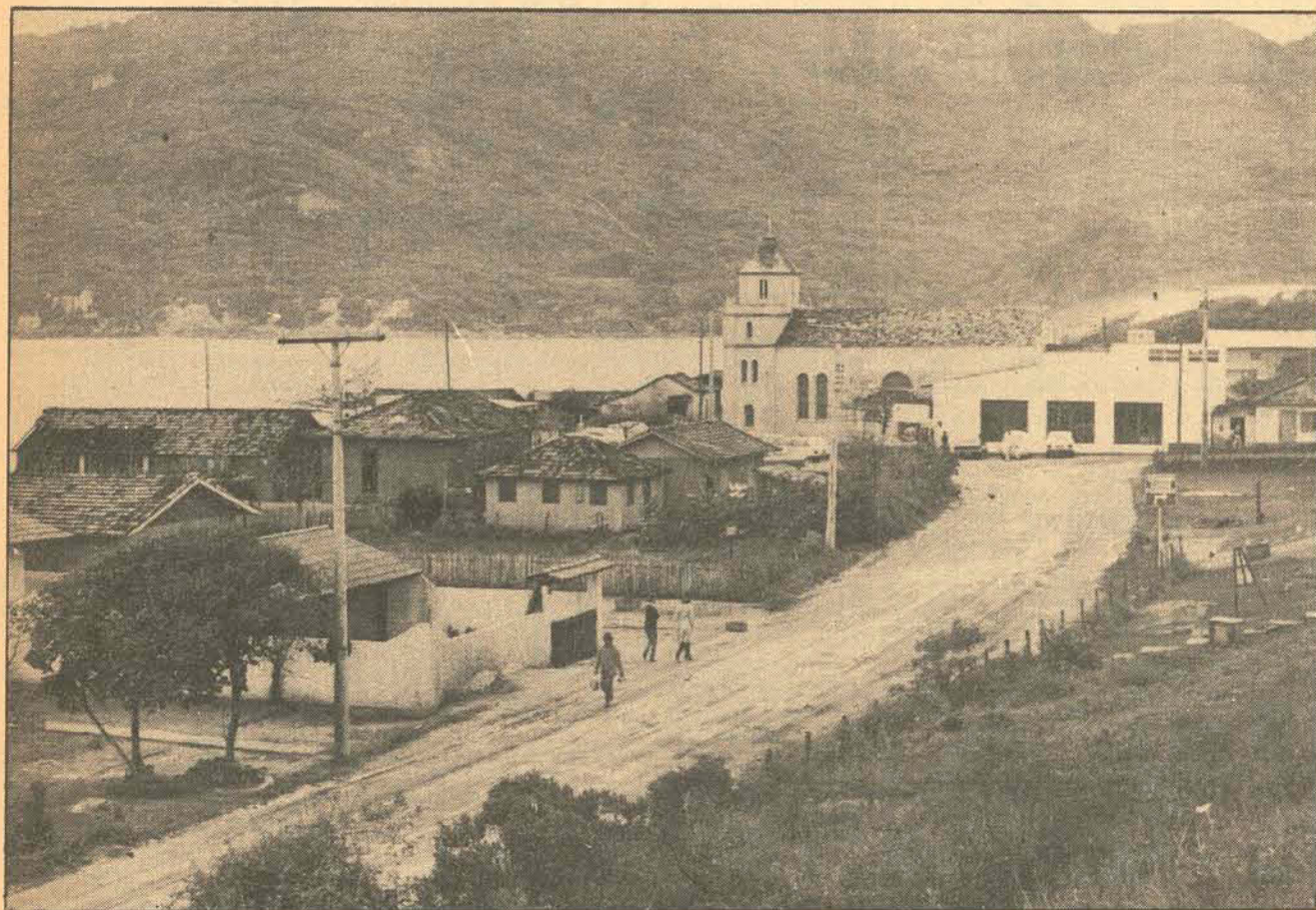
A primeira etapa das obras vai até a Igreja dos Ingleses
