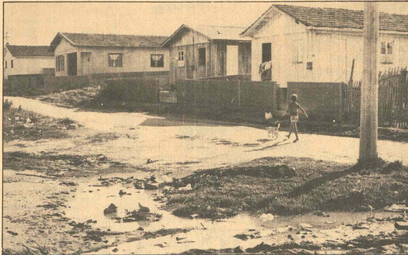
Bairro Ipiranga: péssimas ruas, falta de ônibus, escola...
