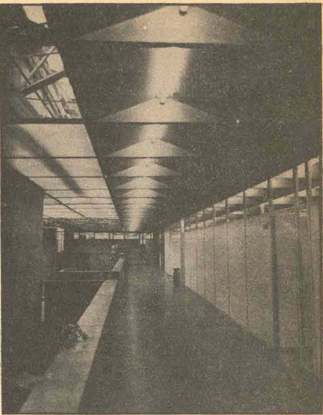
As saídas de ar condicionado podem estar expedindo o pó.
