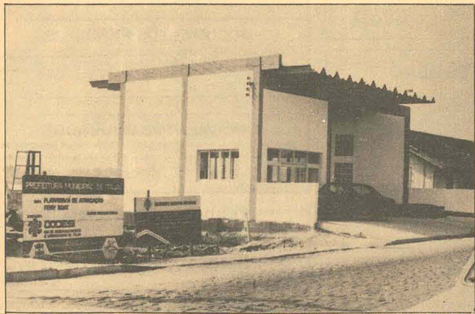
Para o início das operações do ferry-boat, faltam apenas alguns serviços nos atracadouros
