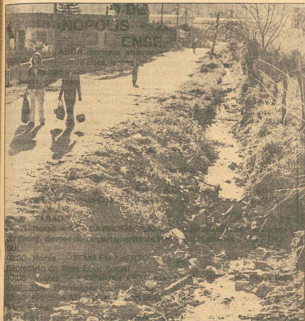
A falta de estrutura básica, água, esgotos e calçamento, caracteriza este loteamento.
