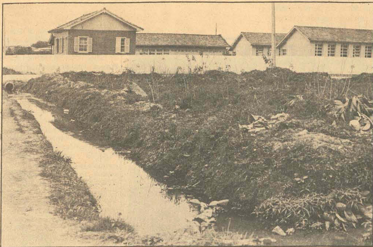
Os alagamentos, em Campinas, são constantes. A situação é insuportável, reclamam os moradores.
