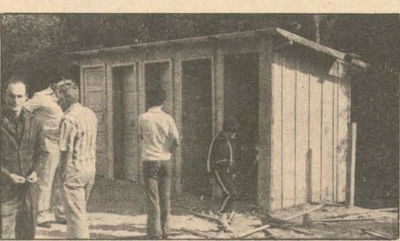
A escola está sem vidraças e com muitas goteiras e as reformas foram iniciadas ontem. Pelo banheiro.
