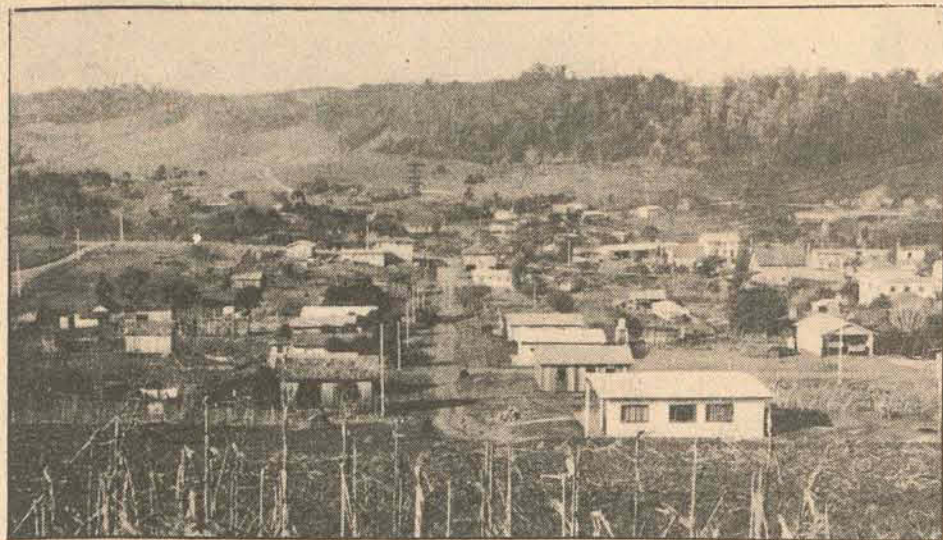
Mais de 200 residências estão instaladas na sede de Iraceminha
