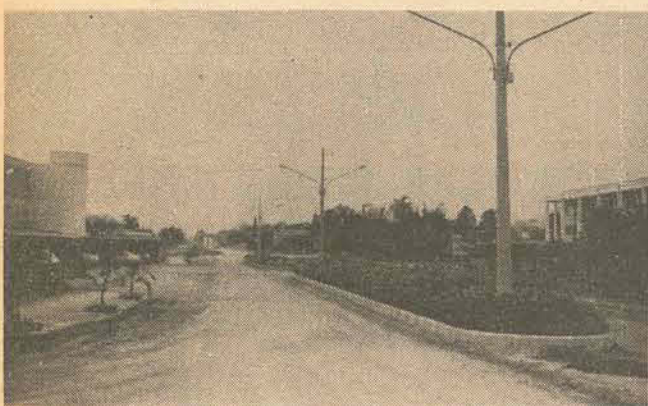
O novo sistema de iluminação, obrigou a substituição de 111 postes e a instalação de 160 luminárias de mercúrio, proporcionando um outro aspecto ao bairro de noite.
