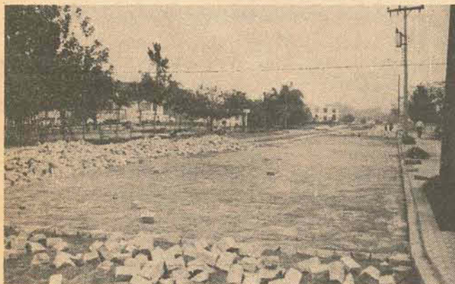
Iniciados essa semana, os trabalhos de calçamento significam a mais importante reivindicação do Jardim Maluche.
