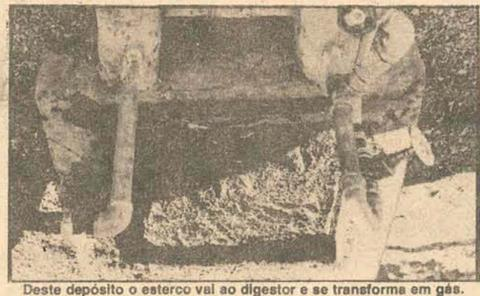
Deste depósito o esterco vai ao digestor e se transforma em gás.
