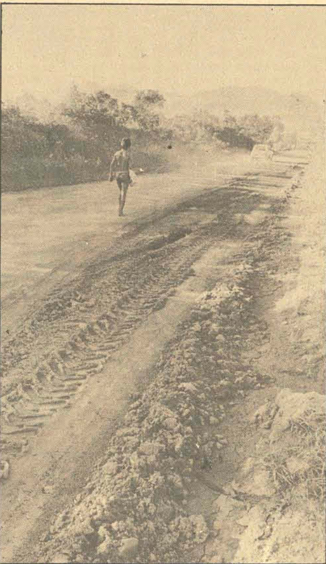
As obras custarão à Prefeitura Cr$ 66 milhões
