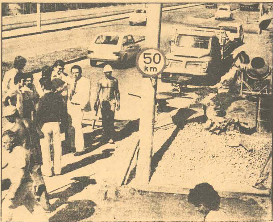
O prefeito e seus assessores visitaram as obras ontem
