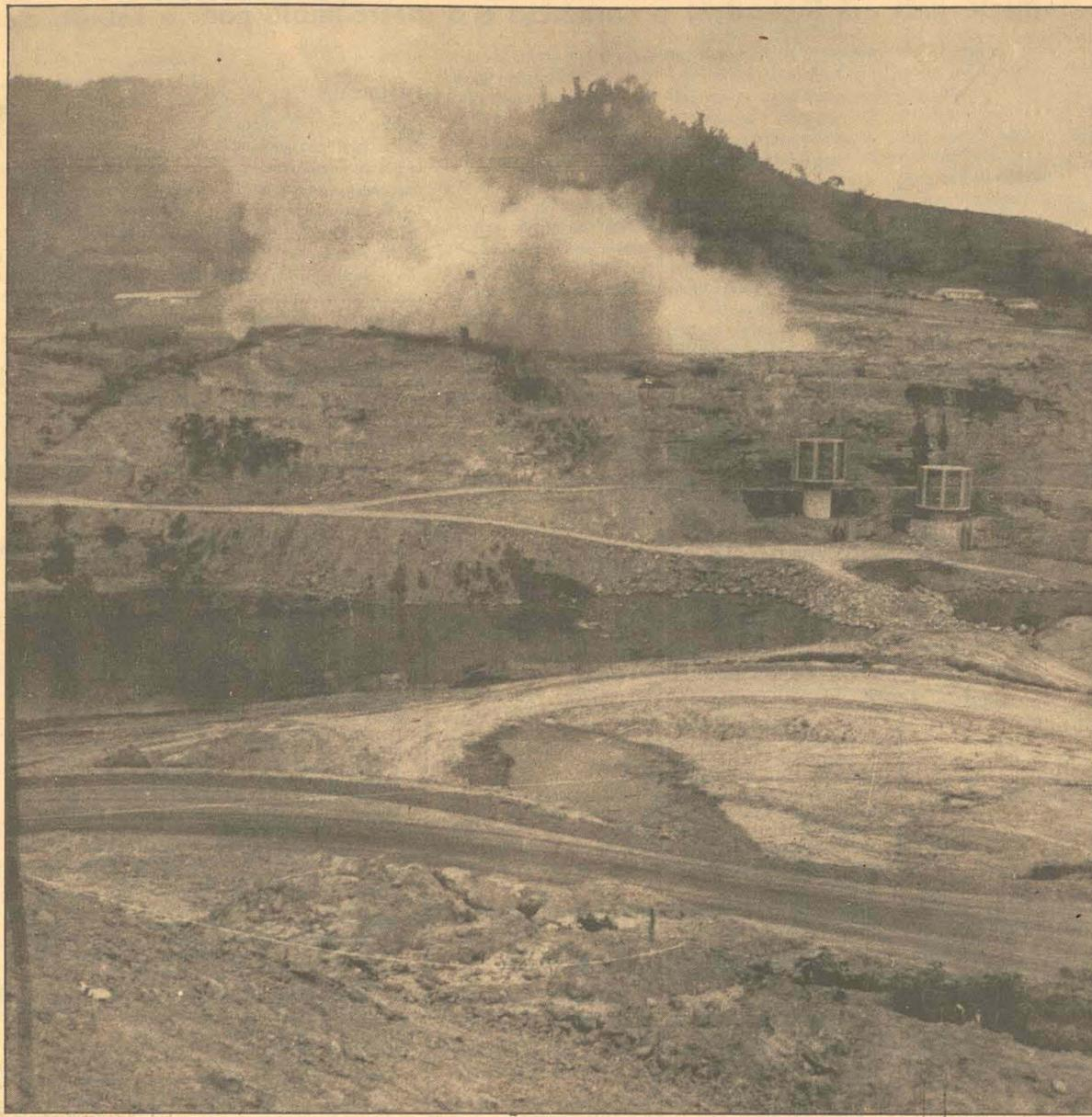
que a Barragem Norte será de terra com enrocamento diferente da Barragem Oeste, feita à base de concreto armado. O DNOS justifica que, pelo tipo de rocha existente no Rio Hercílio, o emprego deste tipo de material transformaria a obra num investimento mais caro, por isso optou-se pela terra e pedra.
