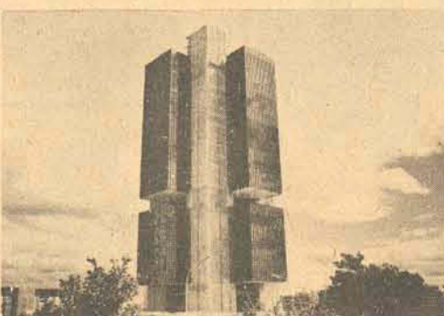
Construção do Edifício-Sede do Banco Central em Brasília. 130.000 m2 de área construída, 140.000 m3 de concreto.
