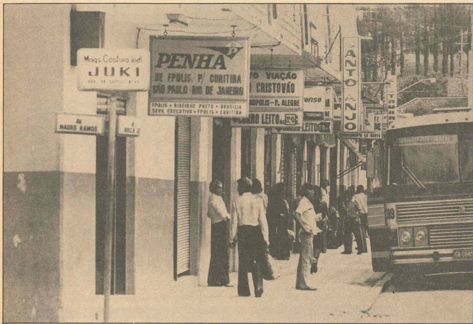
A situação do prédio da rodoviária é vergonhosa: sujeira, desconforto...
