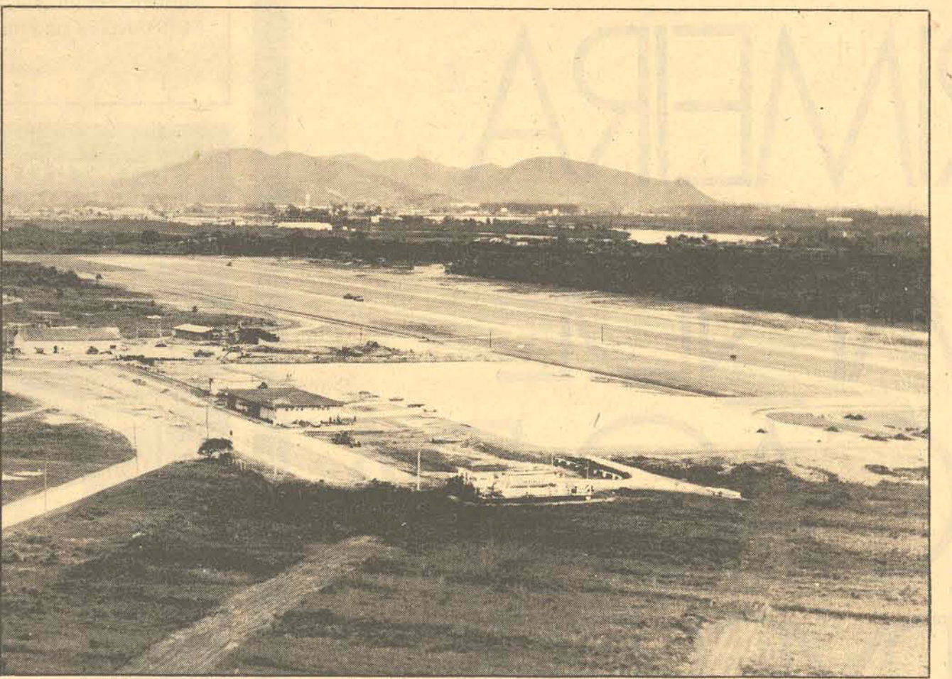
A nova pista tem uma extensão de 1.700 metros e largura de 50 metros.
