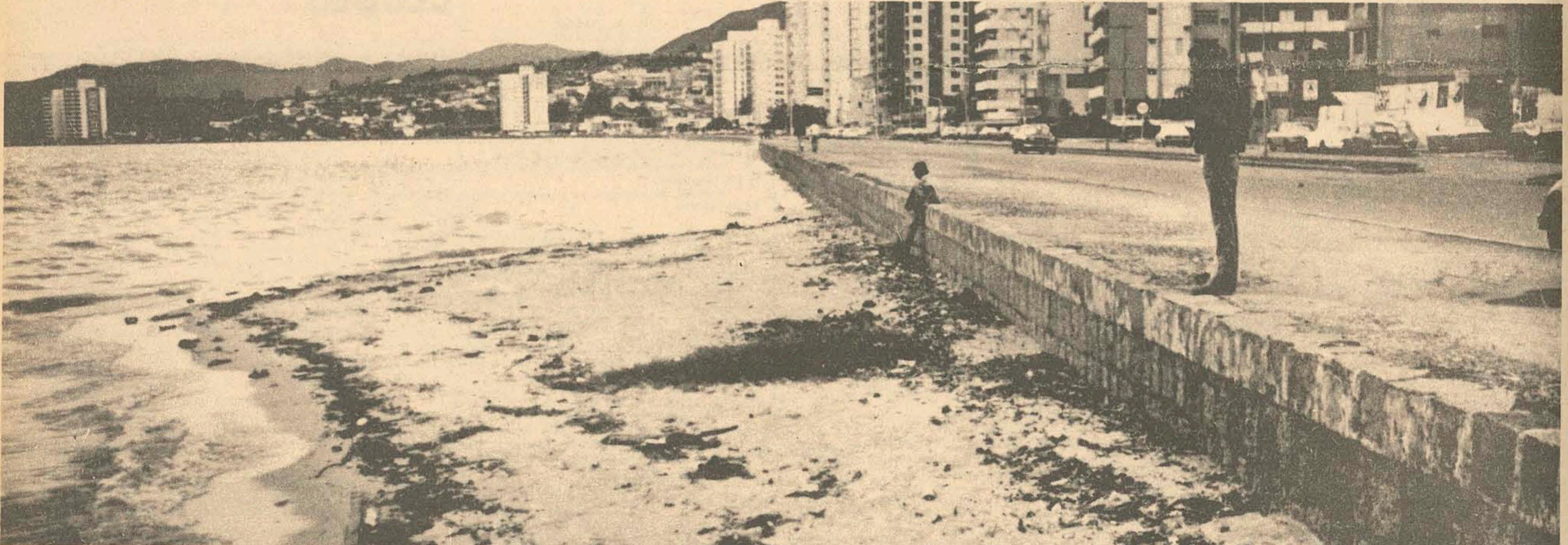
Os dejetos lançados na Beira-Mar Norte, represados pelas obras da Via de Contorno, estão causando sérios problemas e ameaçam as residências.
