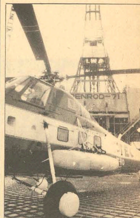
A empresa aérea Votec, auxilia no transporte de equipamento leve e pessoal. A Penrod 71 tem heliporto.
