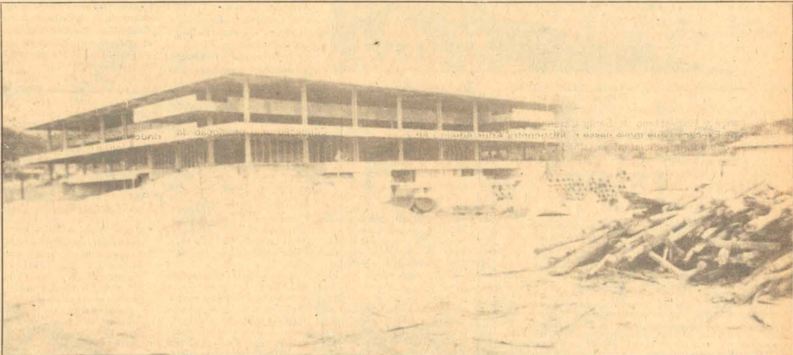
Na estrutura, de cinco pavimentos, foram utilizados 12 mil metros cúbicos de concreto.
