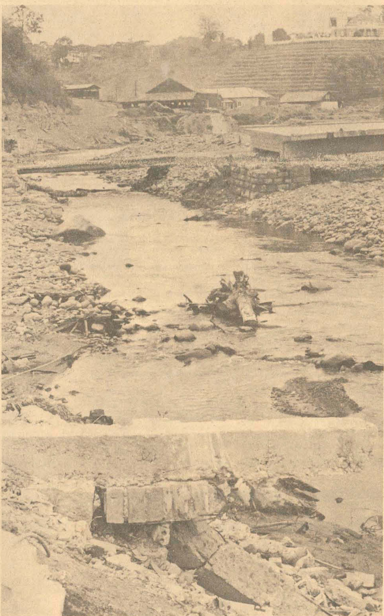
Os problemas de esgoto e rios poluídos exigem a canalização de grande volume de recursos para Santa Catarina
