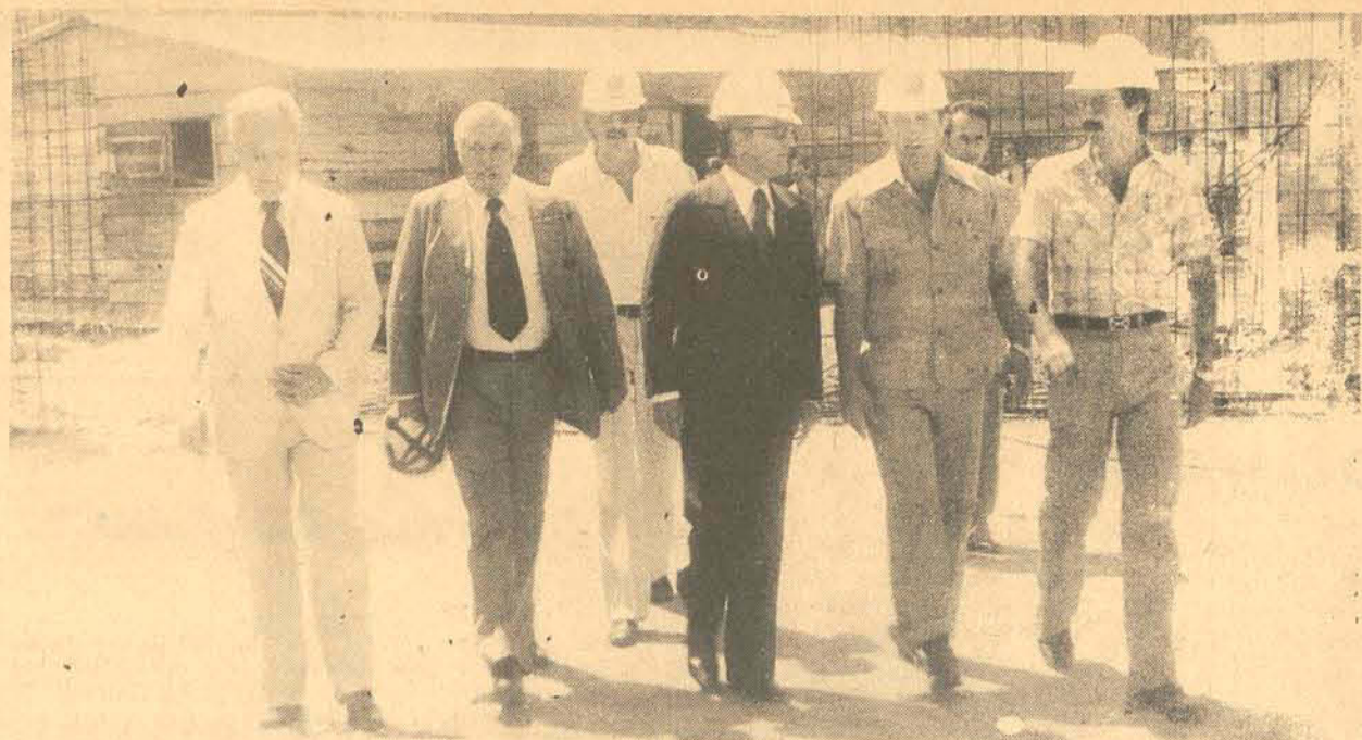
Com capacete de segurança, o Chefe do Executivo inspecionou as obras do terminal graneleiro.
