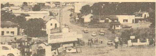
INÍCIO DAS OBRAS DO PORTO SECO
