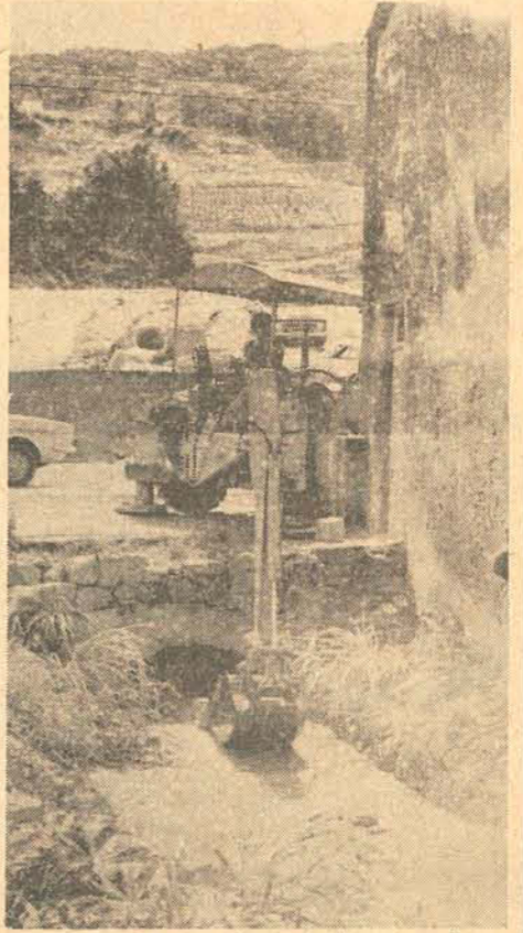
Retirando o que desceu do "loteamento"
