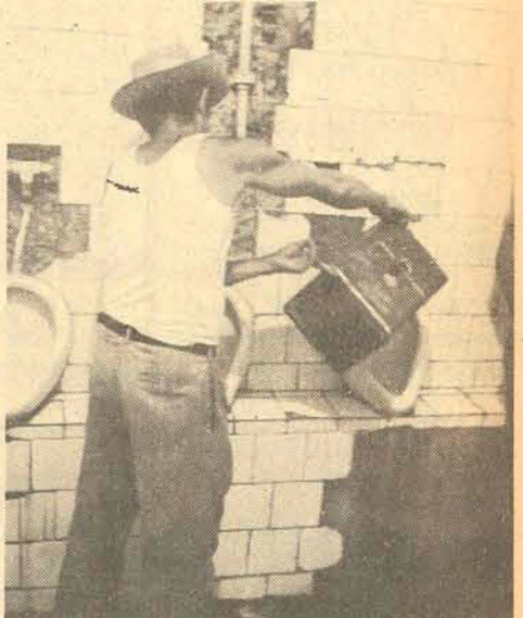
...dos sanitários da precária rodoviária.
