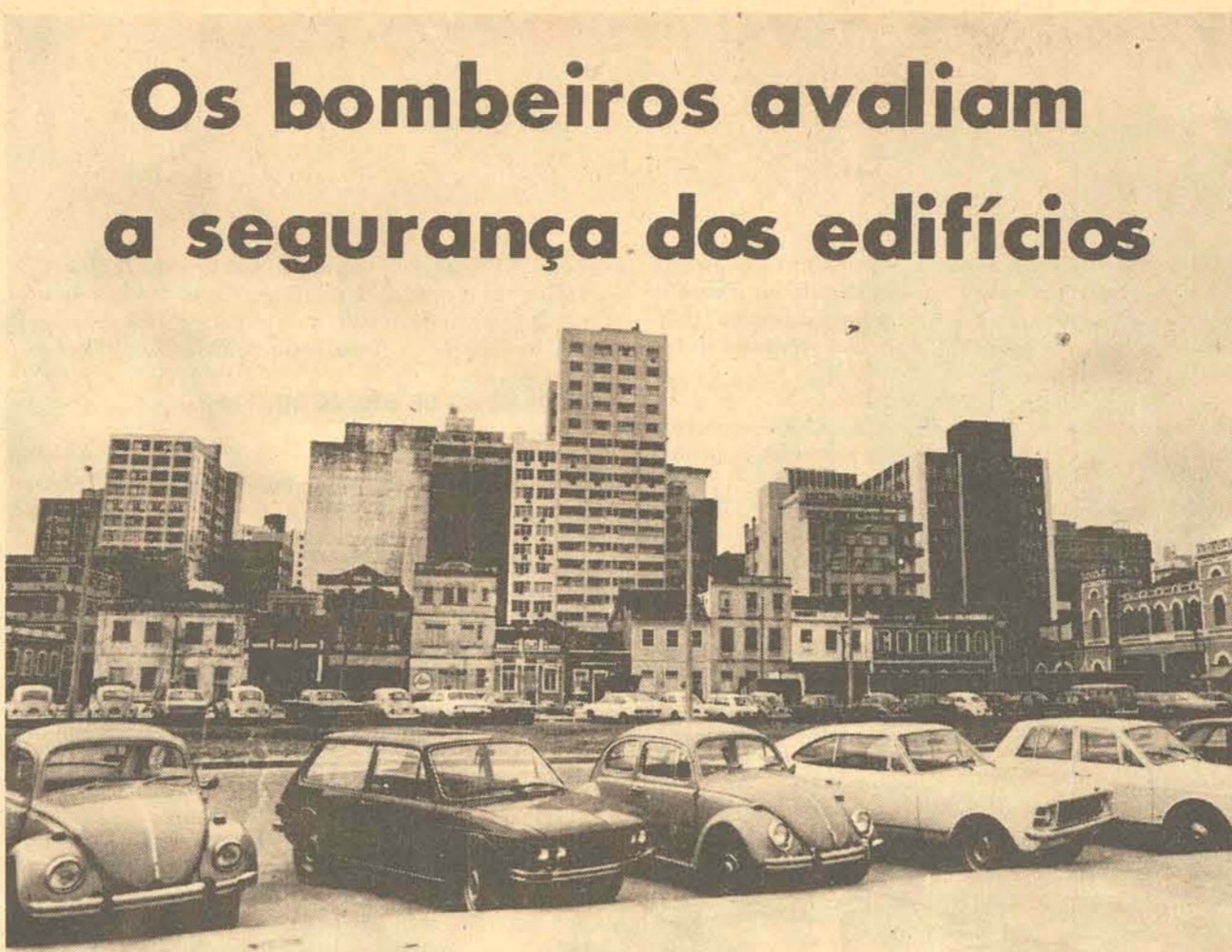
Todas as construções serão cadastradas num levantamento que deverá ser iniciado na próxima semana
