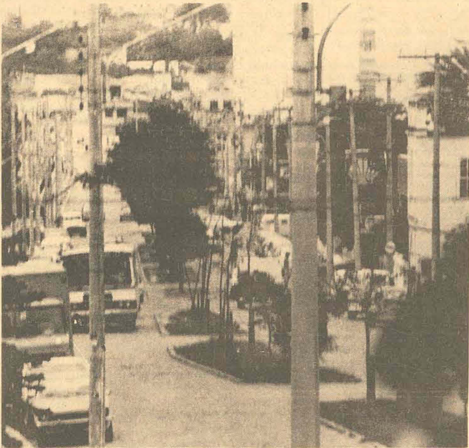
As obras de asfaltamento iniciam quarta-feira. O Detran não sabe ainda se o tráfego será interrompido.
