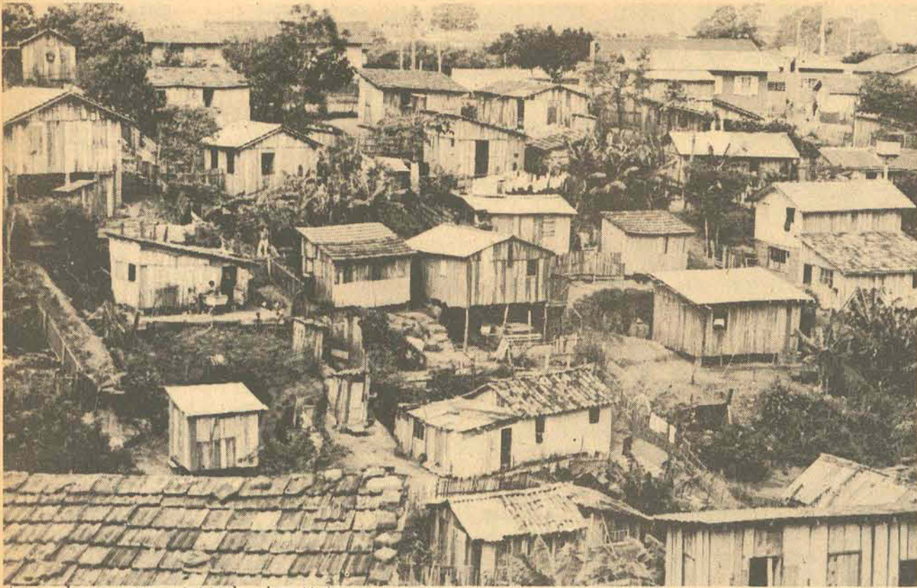
A terraplanagem para o início das obras já riscou...
