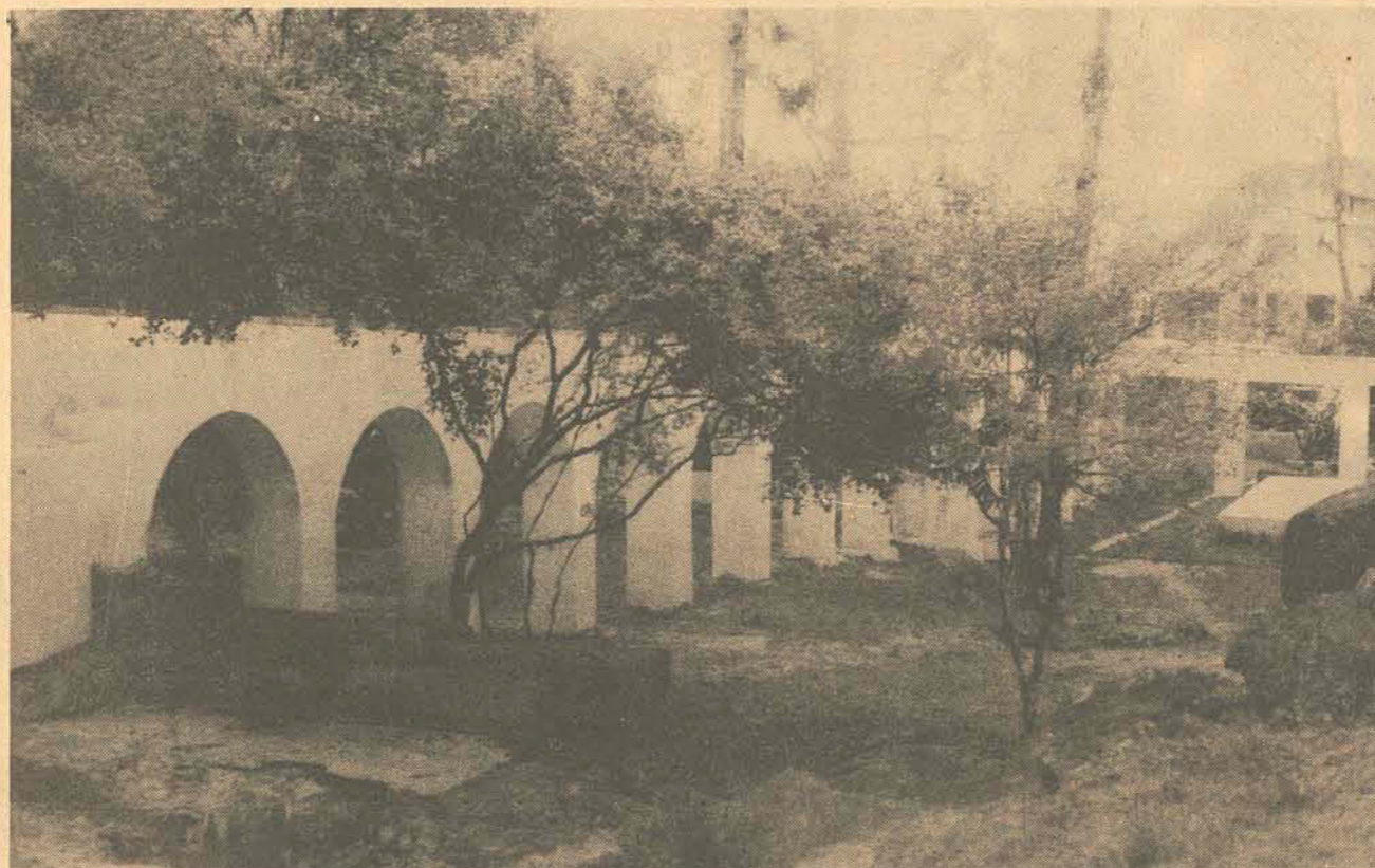
Os trabalhos no aqueduto aliam a prática à restauração da antiga beleza
