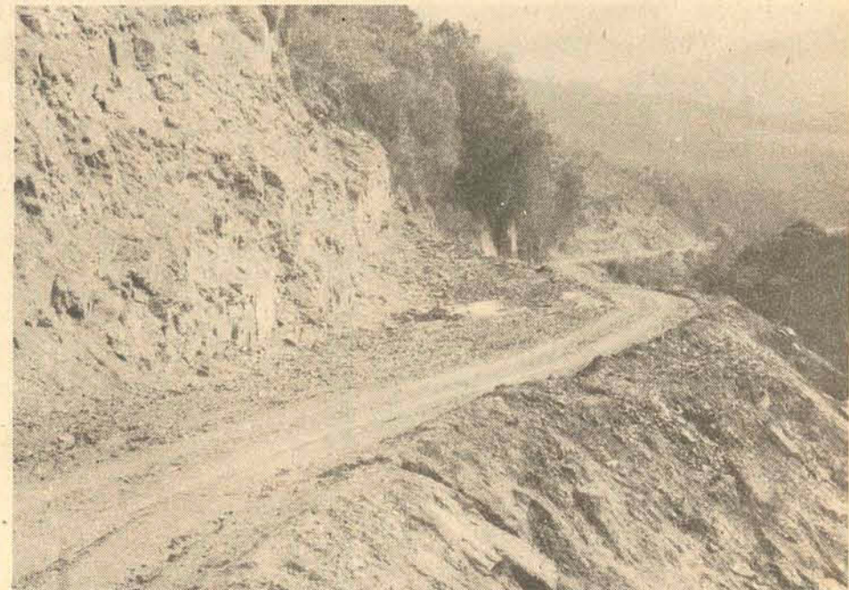
Alargamento da estrada de Serra Albertina
