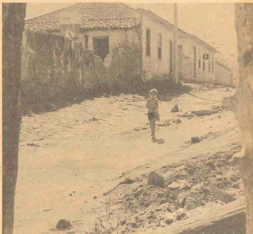
A promessa de calçar Santo Antônio não foi cumprida (P. 15).
