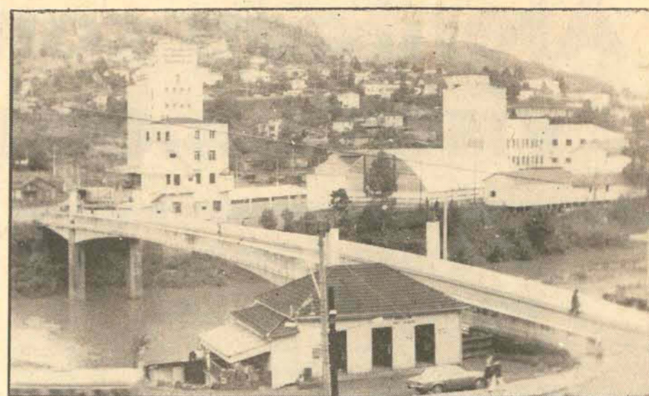
A ponte condenada, ligando Joaçaba a Herval d'Oeste.
